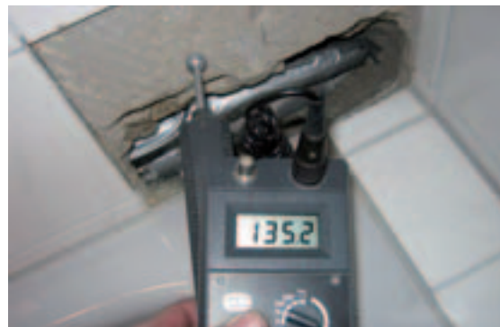
Das Messgerät zeigt die Feuchtigkeit in der Wand
